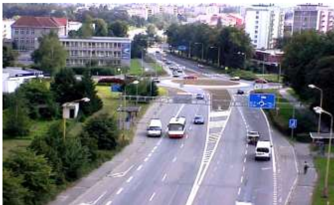
Obr. 4 Situace po přestavbě průsečné křižovatky na okružní
