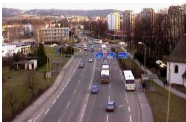
Obr. 3 Původní situace – průsečná křižovatka silnic I/35, I/57 a II/150
